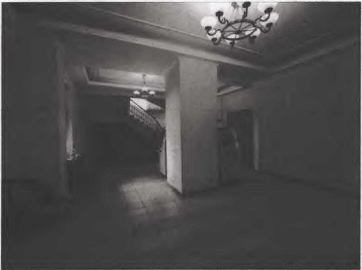
Місце оренди. Перший поверх. Хол лівого крила. Косоури, колона, перекриття, цегляне мурування автентичні
